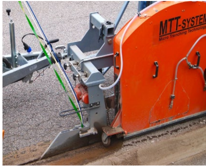
Abbildung 28: Fugenschneidmaschine mit Legeschwert
