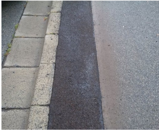
Abbildung 33: Überfräsen eines Reststreifens mit einer 30cm Fräse
