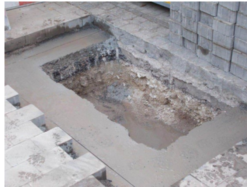
Abbildung 9: Grube mit Pflaster und zusätzlicher Tragschicht, Rückschnitt der Betontragschicht
