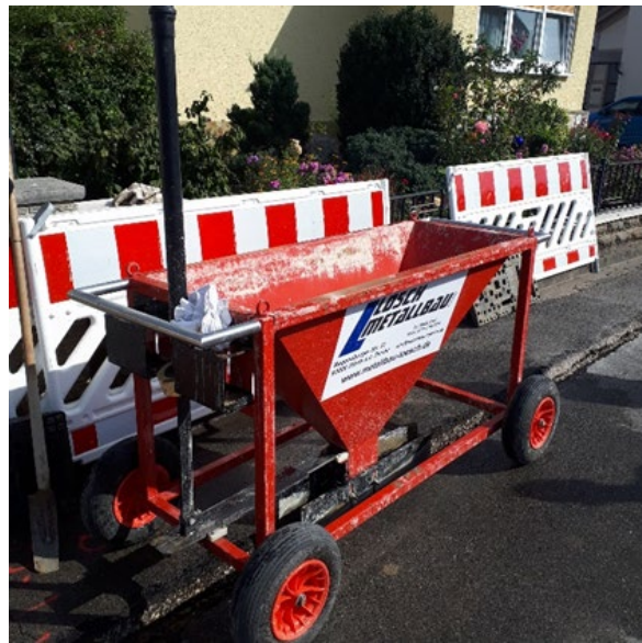
Abbildung 39: Beispiel für Einfüllgerät für Verfüllmaterial ohne Verschmutzung der Asphaltkanten
