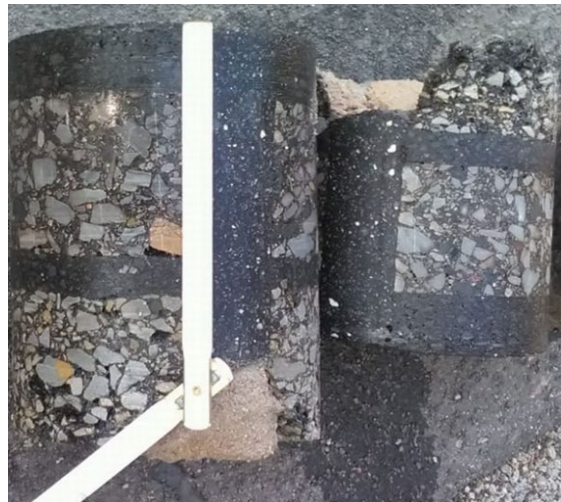
Abbildung 32: Bohrkern eines mit HMG 0/3 hergestellten Trenches 6 cm
