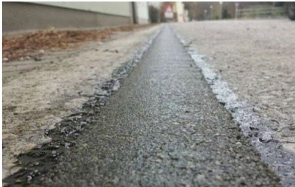
Abbildung 22: Wiederhergestellte Oberfläche
