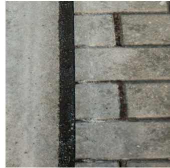
Abbildung 30: Wiederhergestellte Fuge Trenchverfahren III
