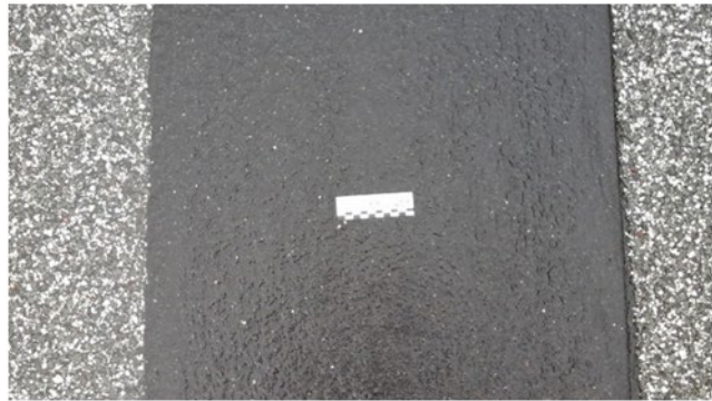
Abbildung 34: Beispiel für die gerade Abschlußkante des Trenches mit HMG 0/3
