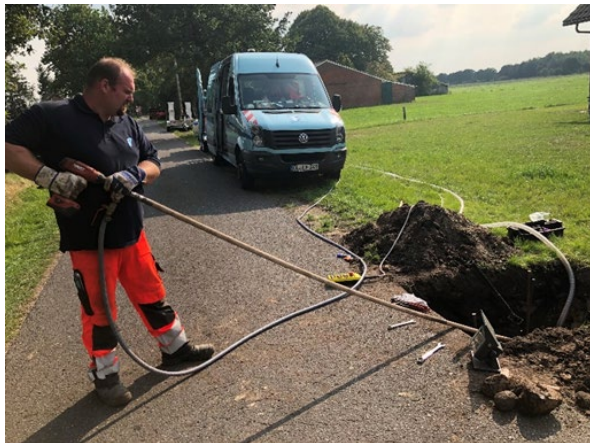
Abbildung 15: Mechanische Unterstützung beim Bohrvortrieb durch Akkuschauber
