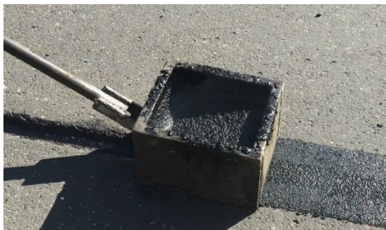
Abbildung 31: Einbau von Gussasphalt als Deckschichtmaterial beim Trenching
