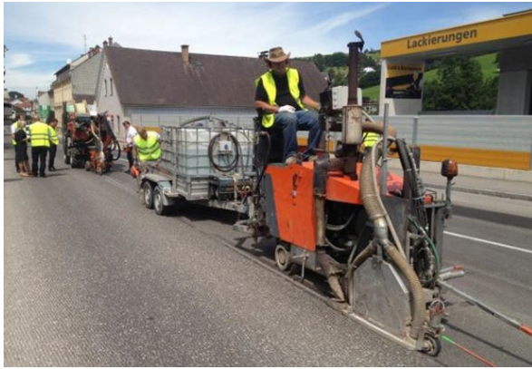
Abbildung 20: Schneidmaschine mit Absaugvorrichtung Abbildung 21: Verlegen, Sand einbauen und Verfüllen
