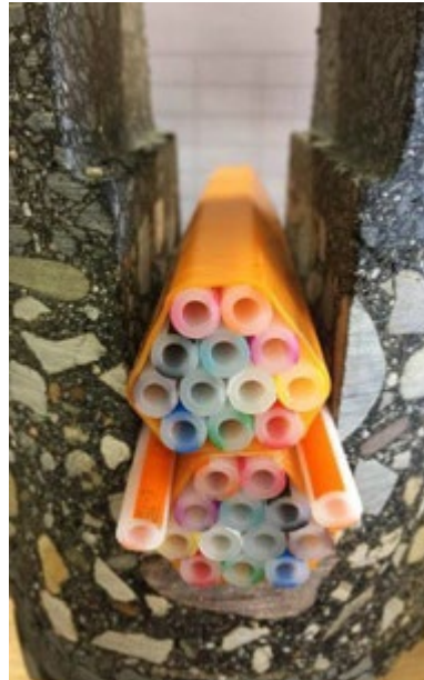
Abbildung 25: Verlegung im Trench Abbildung 26: Mittelbreiter T-Schlitz Abbildung 27: Fertig verfüllter Trench
