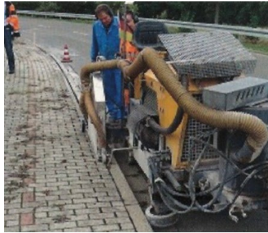
Abbildung 29: Fugenschneidmaschine beim firmenspezifischen "CurbTrenching"
