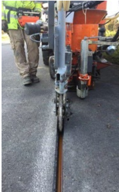
Abbildung 25: Verlegung im Trench Abbildung 26: Mittelbreiter T-Schlitz Abbildung 27: Fertig verfüllter Trench
