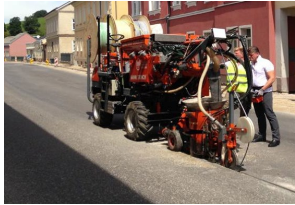
Abbildung 20: Schneidmaschine mit Absaugvorrichtung Abbildung 21: Verlegen, Sand einbauen und Verfüllen
